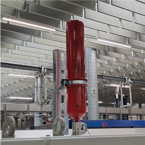
Im Brandfall löst die AMFE thermisch aus, bevor sich der Brand ausbreiten kann. So sind die Mitarbeitenden zu jedem Zeitpunkt vor den Gefahren eines Brandes geschützt. Dank der AMFE werden Produktions- und Versandausfall sowie Anlagenstillstand verhindert. Ein Verlust der Ware durch Brandfolgen kann nahezu ausgeschlossen werden.
