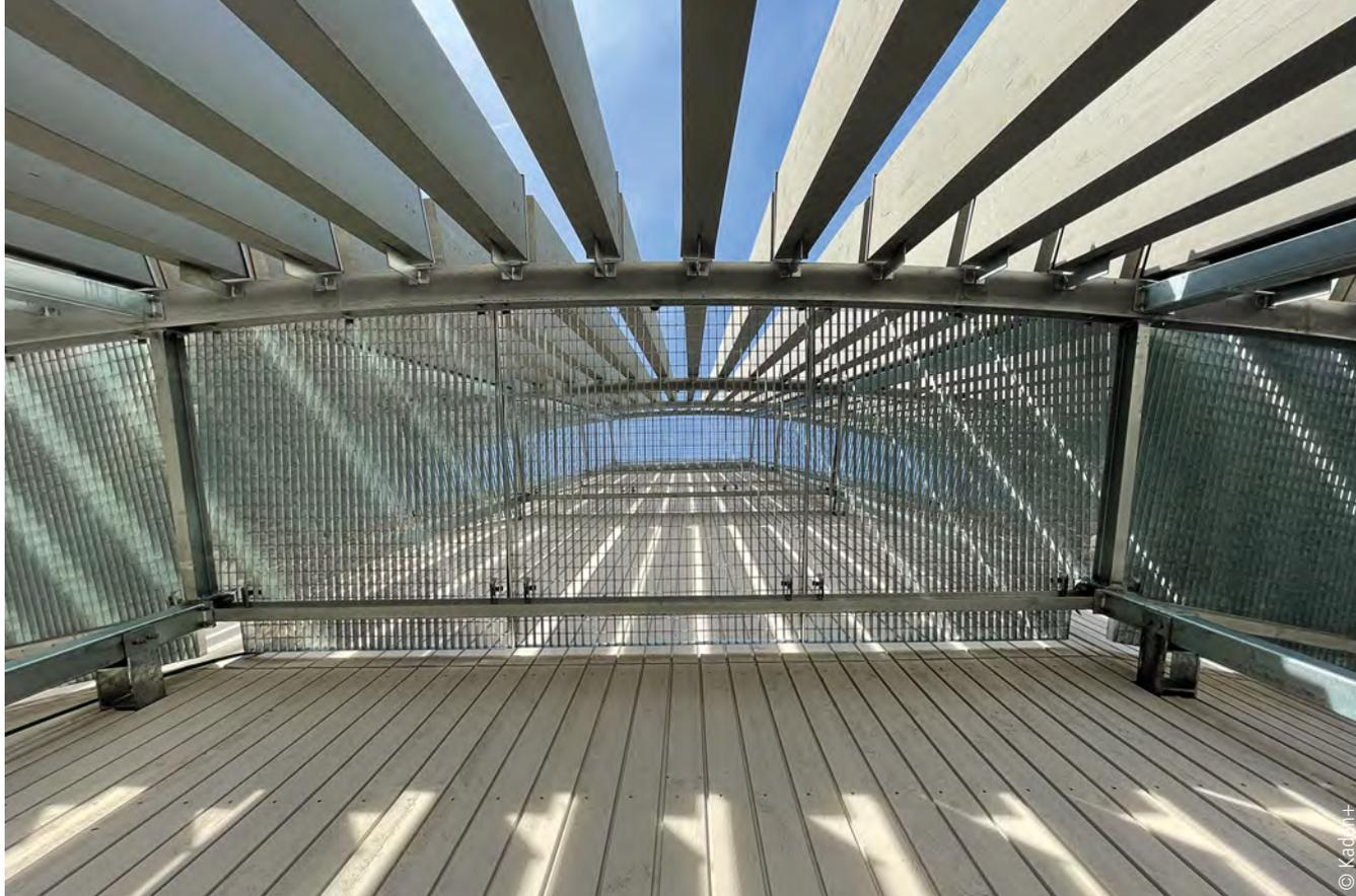
Abb. 13: Den Theaterbau umgeben 1,50 m breite Wartungsgänge und eine zweite Fassade aus 28 cm tiefen und 12 cm breiten BSH-Lamellen
