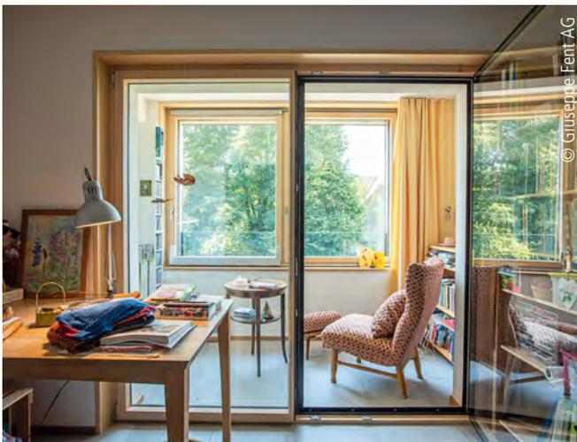
Abb. 4: Die Loggien wurden geschlossen und zu Wintergärten ausgebaut. Aus schallschutztechnischen Gründen erhielten sie nach außen und innen jeweils eine Dreifach-Isolierverglasung.
