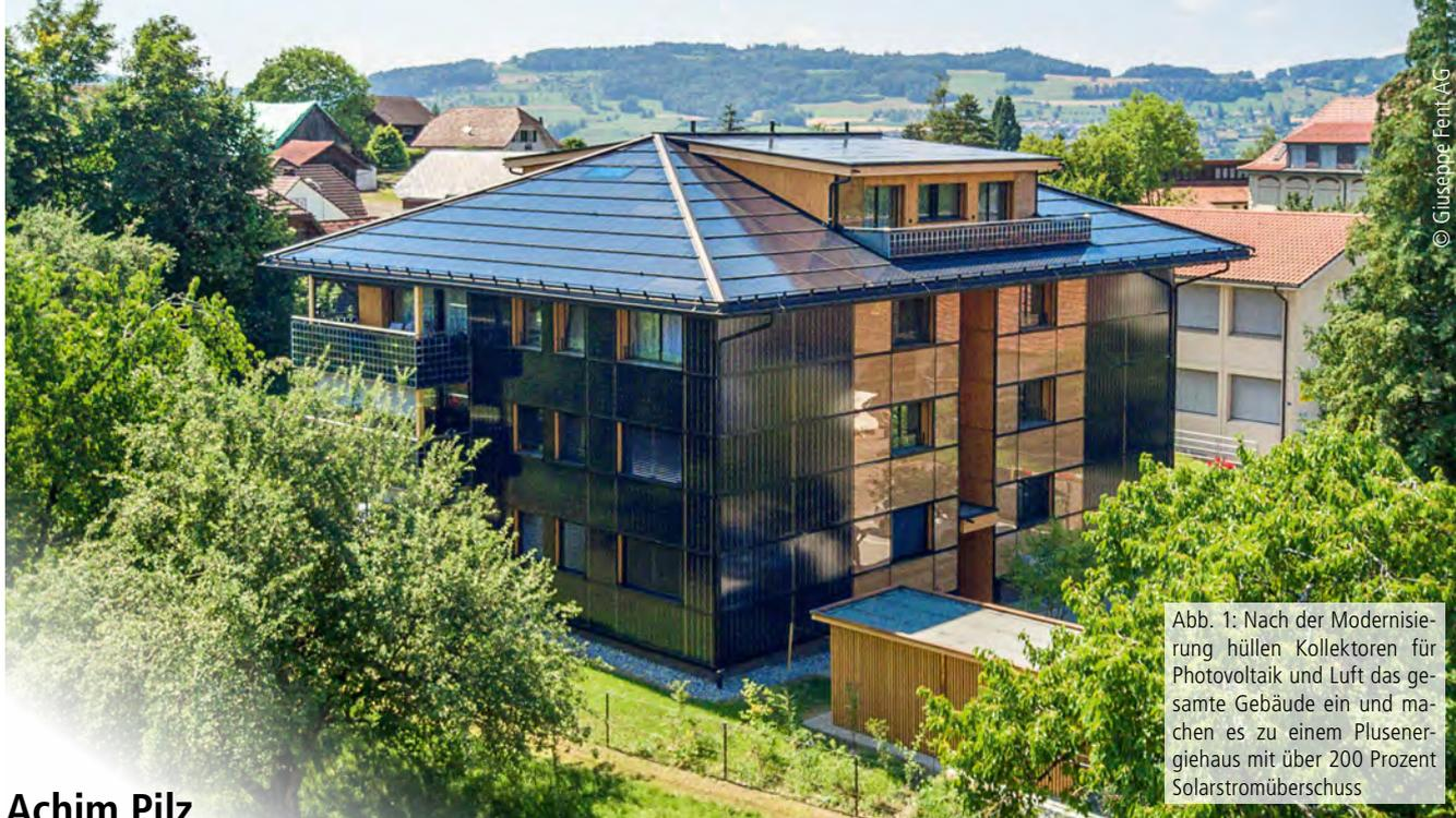
Abb. 1: Nach der Modernisierung hüllen Kollektoren für Photovoltaik und Luft das gesamte Gebäude ein und machen es zu einem Plusenergiehaus mit über 200 Prozent Solarstromüberschuss
