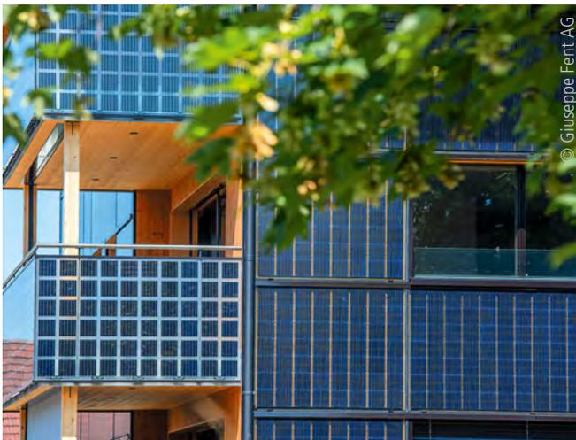
Abb. 6: Die Luftkollektoren mit Holzabsorbfern in der Fassade sind größten Teils mit semitransparenten PV-Modulen belegt
