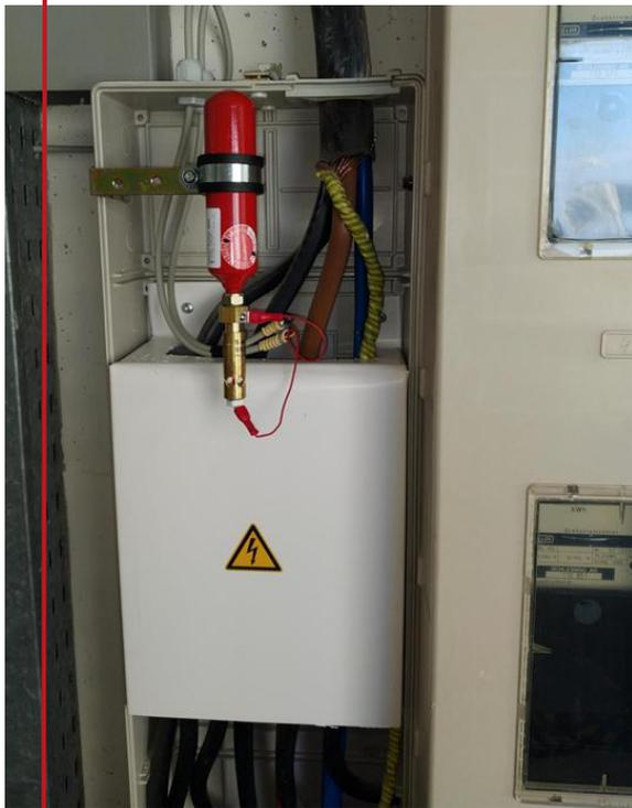
Die Vorteile der AMFE sind unverkennbar. Sie erkennt den Brand bereits in der Entstehungsphase, löscht schnell und vor allem rückstandsfrei. Zudem wird nach dem Auslösen der hier verbauten S-AMFEen eine Blitzleuchte aktiviert, sodass eine Alarmierung des Hausmeisters und/oder der Feuerwehr durchgeführt werden kann.
