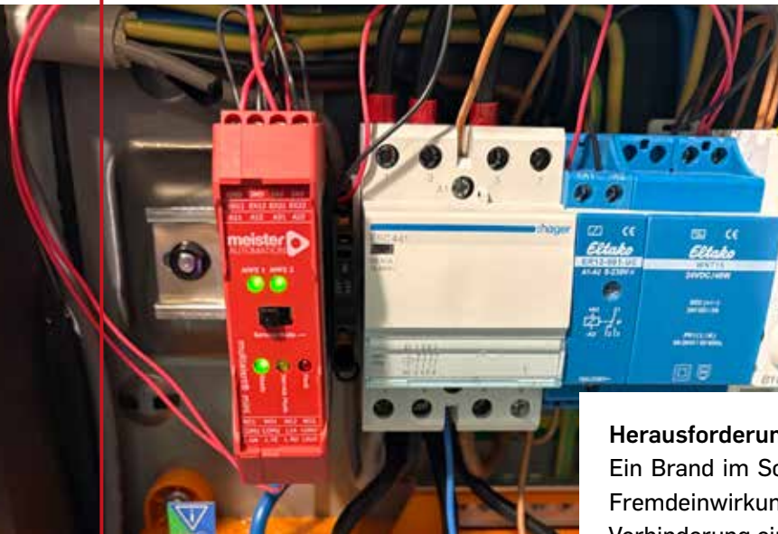
Abschaltfunktion des Schaltschrankes (u. a. für Wärmepumpe und elektrische Zusatzheizung) sowie Sperrung der Zuschaltung der Notstromversorgung aus der Speicherbatterie.
