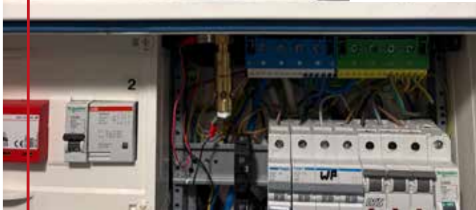
Integration der R-AMFE Einheit im Schaltschrank
